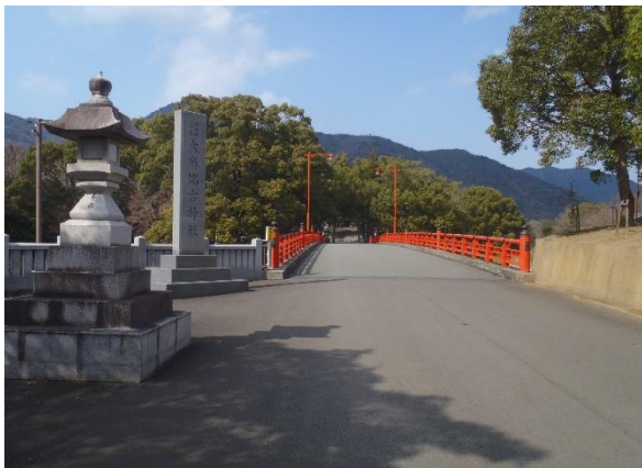
② 大麻山比古神社前の橋
